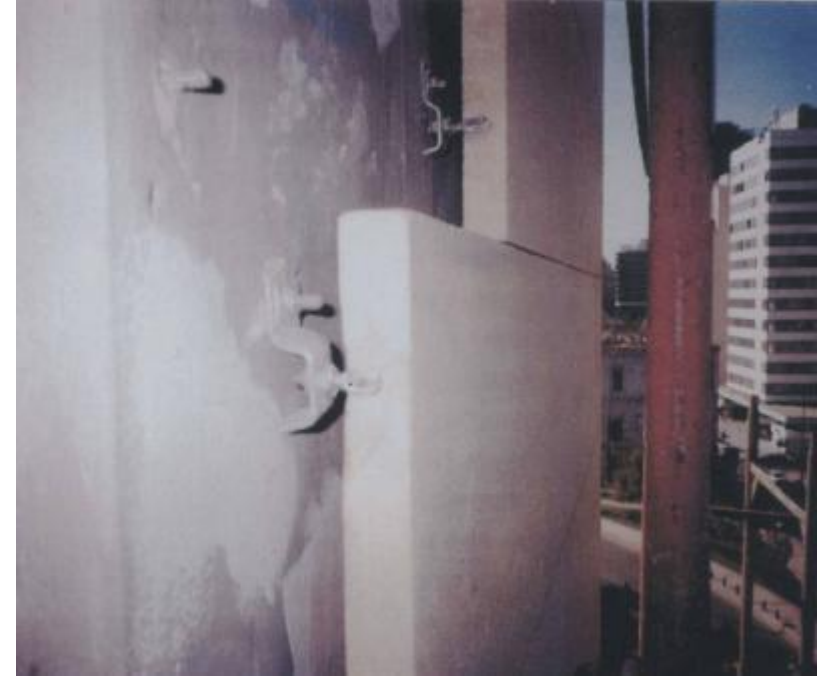
أ- تربيطة ميكانيكية لقطع الحجر بدون استخدام الخرسانة
