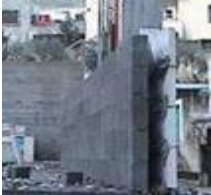
ب- بعد بناء القطع الحجرية والطوب يتم صب الخرسانة بينهما
